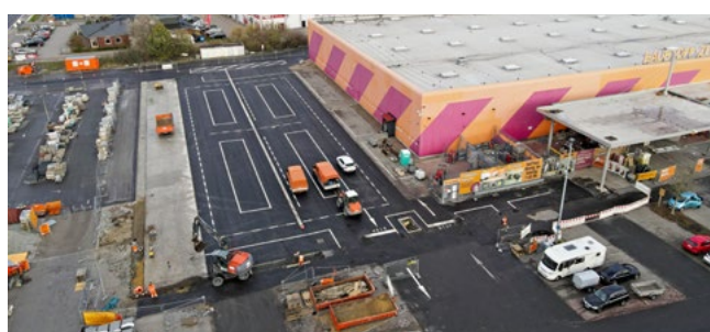
Referenz Außenflächenerstellung: Hornbach, Bremerhaven.
