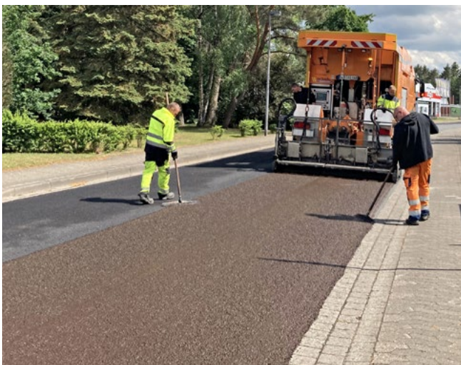
Dünne Asphaltdeckschichten in Kaltbauweise (DSK) in allen Variationen,
