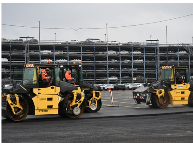
Asphaltsanierungsarbeiten im Containerhafen der BLG, Bremerhaven, BLG
