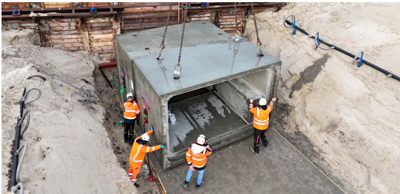
Grabendurchlass-Erneuerung auf der A27, Hagen im Bremischen, Die Autobahn GmbH
