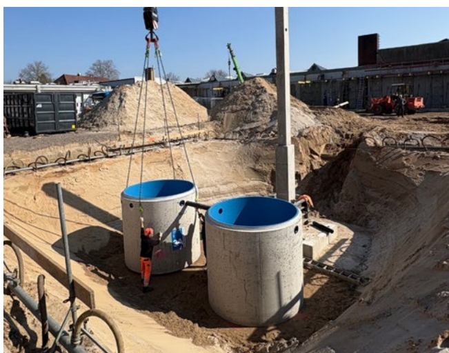
Einbau von AWA-Anlagen
