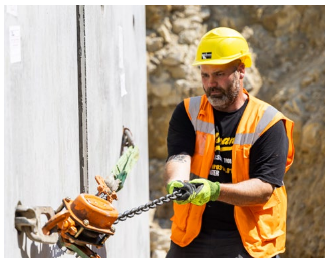
Zusammenführen eines Rahmendurchlasses
