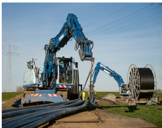
Verlegung von Leerrohren in Berne
