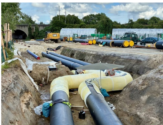
Erneuerung der Fernwärmeleitung Oststrang, Bremen, Wesernetz Bremen
