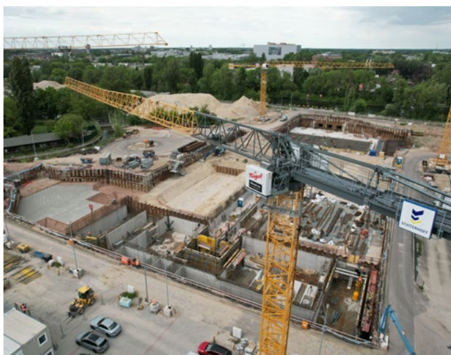
Errichtung der neuen Reinigungsstufen am Klärwerk Ruhleben in Berlin
