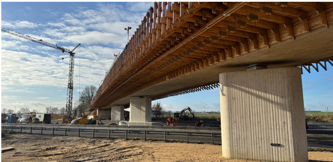
Brücken- und Betonbau
