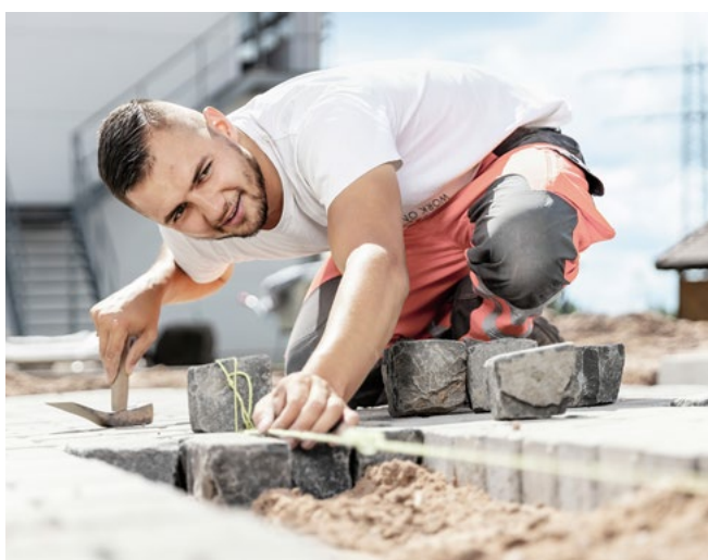
Steinsetzer bei der Arbeit
