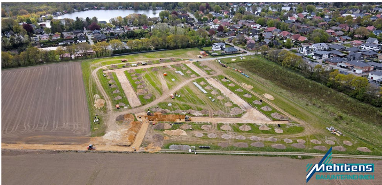
Referenz Erschließung Neubaugebiet: Erschließungsgebiet „Östlich Malerwinkel“, Langen.
