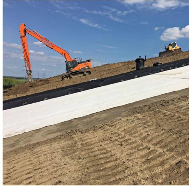
Oberflächenabdichtung einer Deponie: Detail
