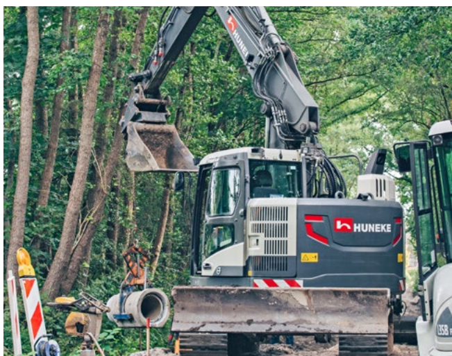
Die Sparte Kanalbau ist einer der Leistungsbereiche der ersten Stunde.
