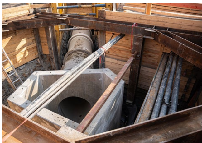
Errichtung eines Abwassersammelschachts mit kreuzenden Versorgungsleitungen in Dresden
