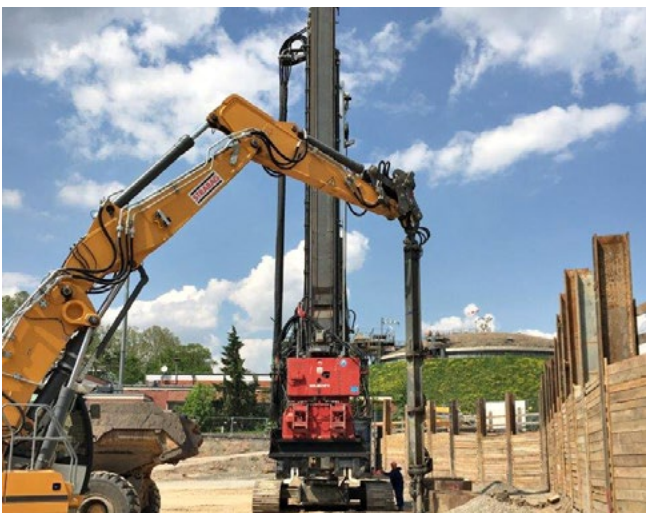
Bodensanierung mittels Wabenverfahren
