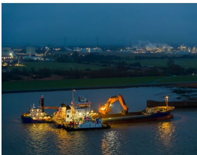
Baggerung FSRU Anleger Brunsbüttel
