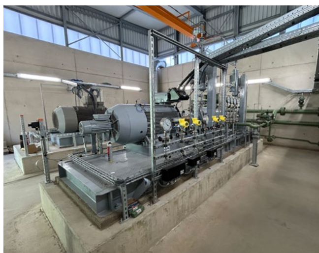
Projekt Erweiterung einer Pumpstation für eine NATO-Pipeline
