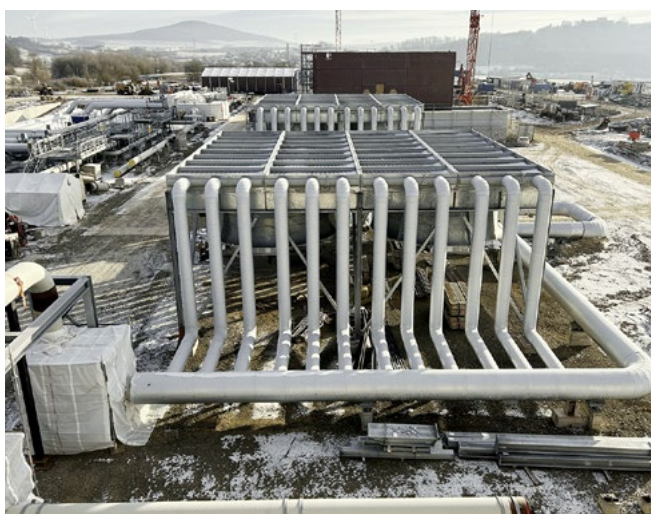
Projekt Rohr- und Stahlbau VS Reckrod
