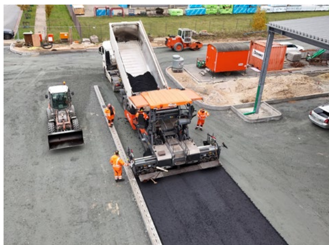
Asphaltarbeiten bei CHS Container Handel, Bremen, CHS
