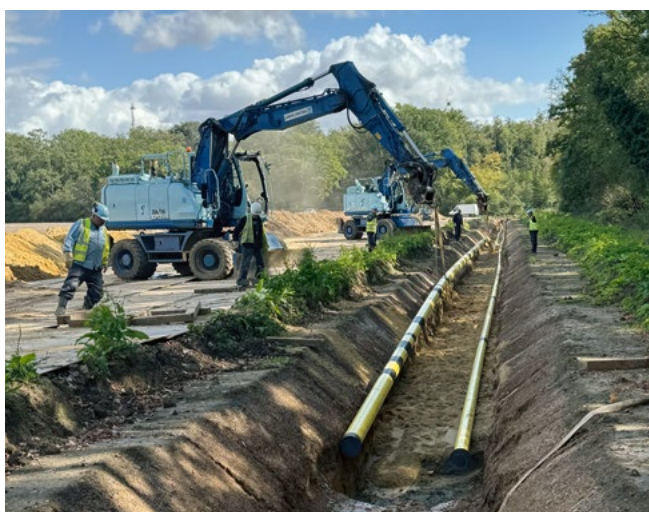
Ausbau Gasrohrnetz im Raum Aachen
