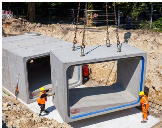
Einsetzen eines Rahmendurchlasses
