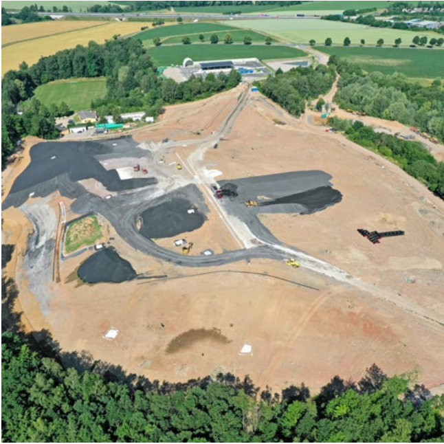
Oberflächenabdichtung einer Deponie: Luftaufnahme
