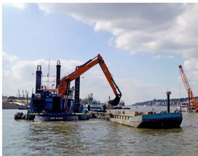
Nassbaggerung Norderelbe am Tollerort
