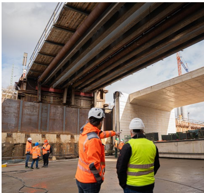
Erstellung eines Trogbauwerks im Zuge einer Ortsumgehung an der Bundesstraße 441 in Wunstorf
