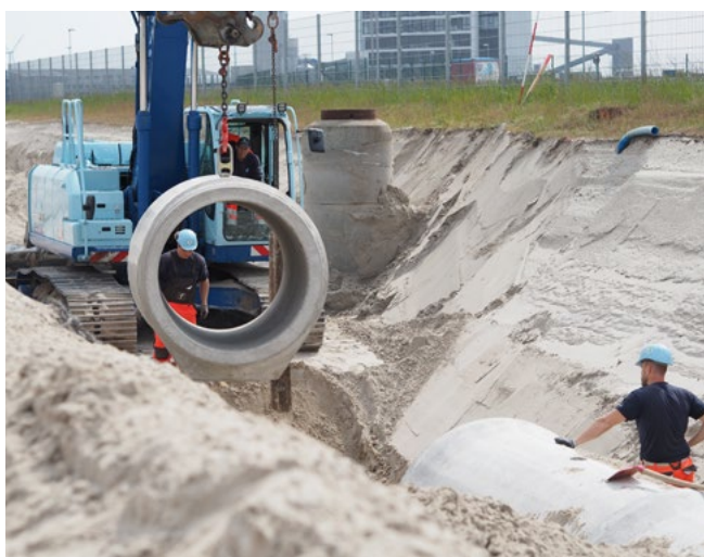
In allen Sparten des Tief- und Rohrleitungsbaus zu Hause
