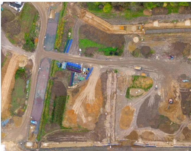
Erschließung in Salzgitter
