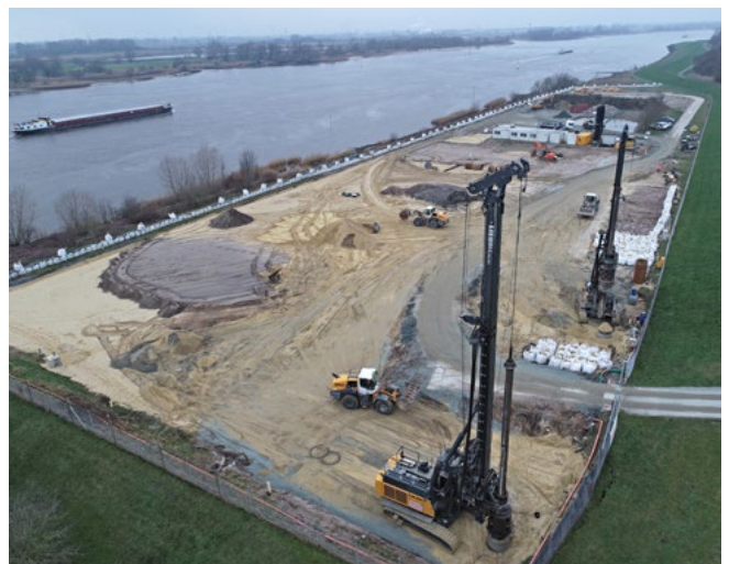
Bodensanierung mittels Großlochbohrung
