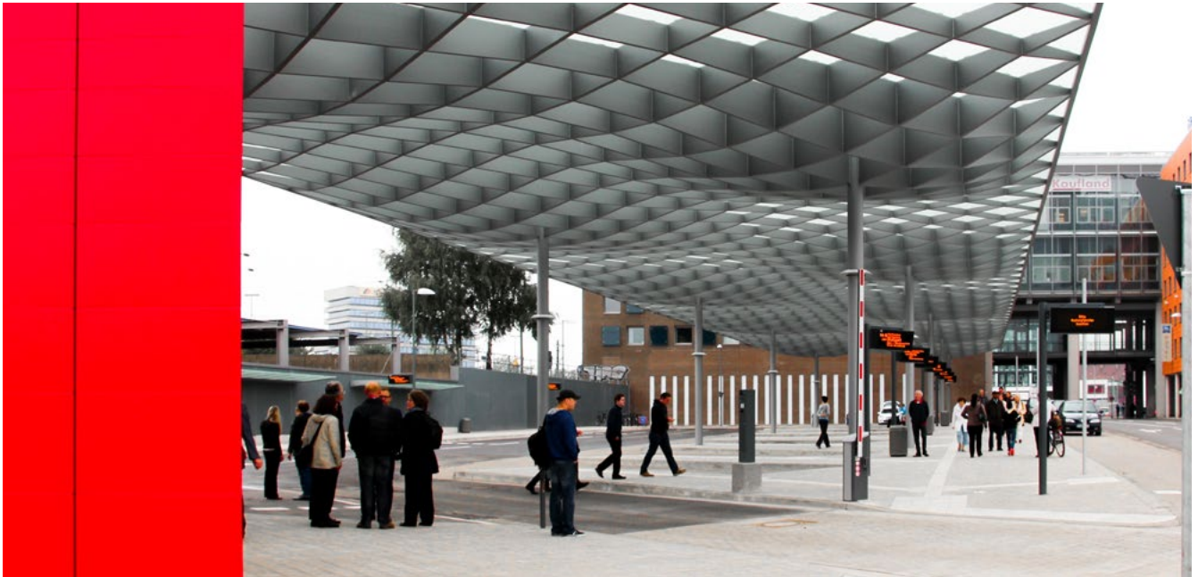
Straßenbau Neubau ZOB Hannover
