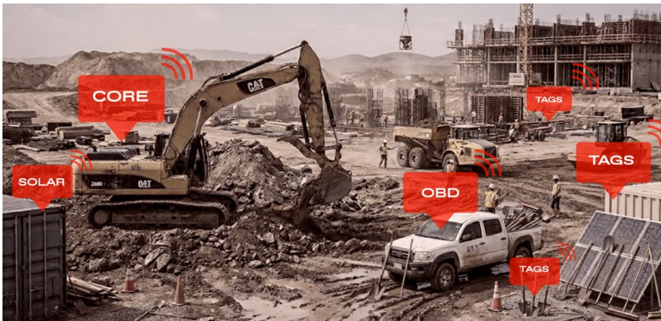
Baustelle mit tracking & IoT
