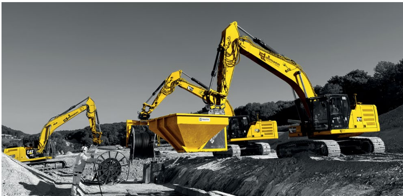
Verlegen von Erdkabeln für den Netzausbau
